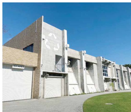
エコリゾート外観。会議のようすは撮影禁止、エコリゾート手前の芝生は、元ごみピットだった場所だ。
