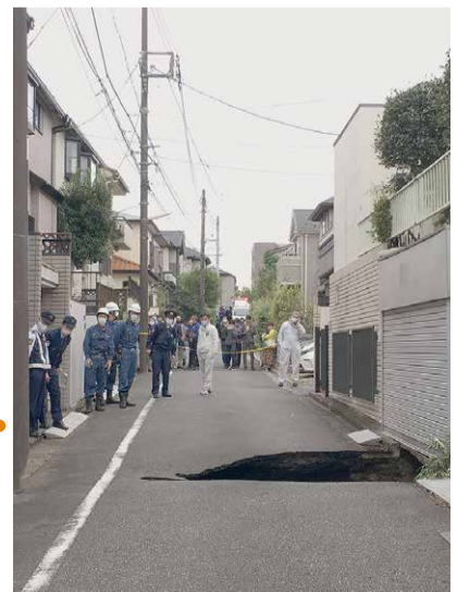
2020年10月18日、東京外かく環状道路のトンネル真上の調布市内住宅街で陥没事故が起きた
