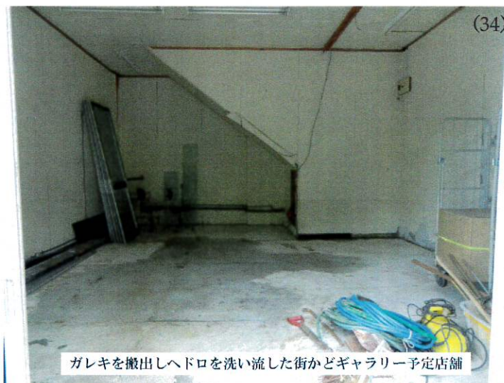
震災後4ヶ月、被災した空き店舗を賃借し、ゾンタハウス開設に向けて補修工事が始まる。
