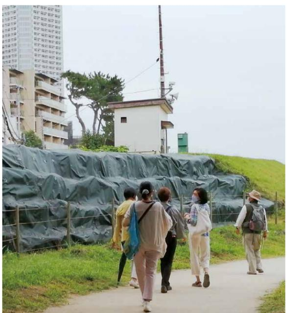
世田谷区二子玉川を流れる多摩川。無堤防区間と、堤防ができたところの境目に、堤防がわりの大型土のうが大量に積み重なっていた
