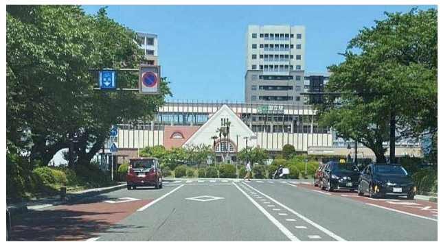
1926(大正15)年創建当時の姿で甦った赤い三角屋根の国立旧駅舎
