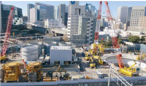
起点駅とされる品川区で始まった、低周波公害が危惧される変電所施設、非常口立て坑等工事。2017年12月25日撮影
